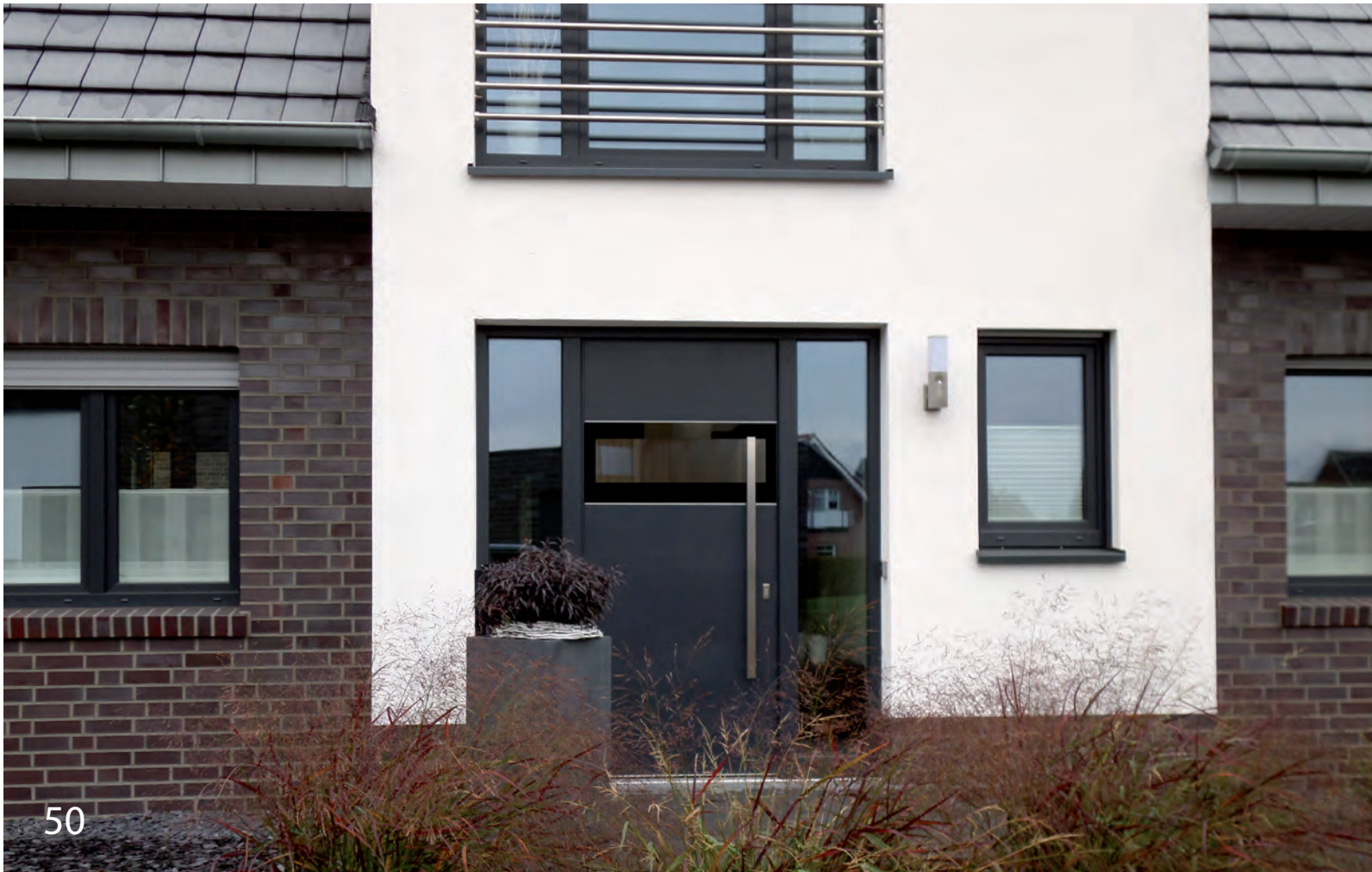
H503: Anthrazit, VA-Stahl-Lisenen 15mm flächenbündig eingelegt, Stufen-ISO-Glas schwarz emailliert
